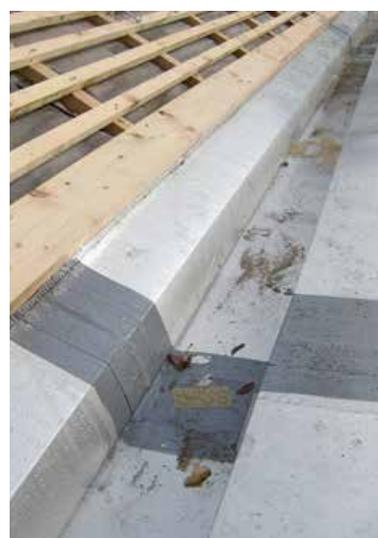
◀◀ Verlegen der Dämmelemente auf der L+D-Folie
