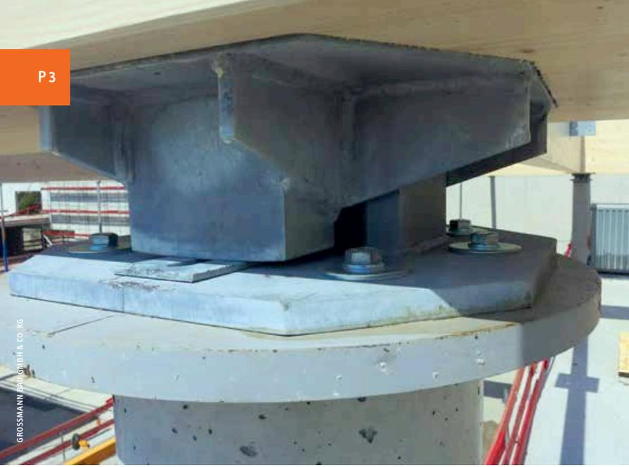
◀ Im Hallenbereich dienen die Stahlbetonstützen mit einem Durchmesser von 40 cm im Hauptachsraster als punktuelle Auflager für die Dachkonstruktion
