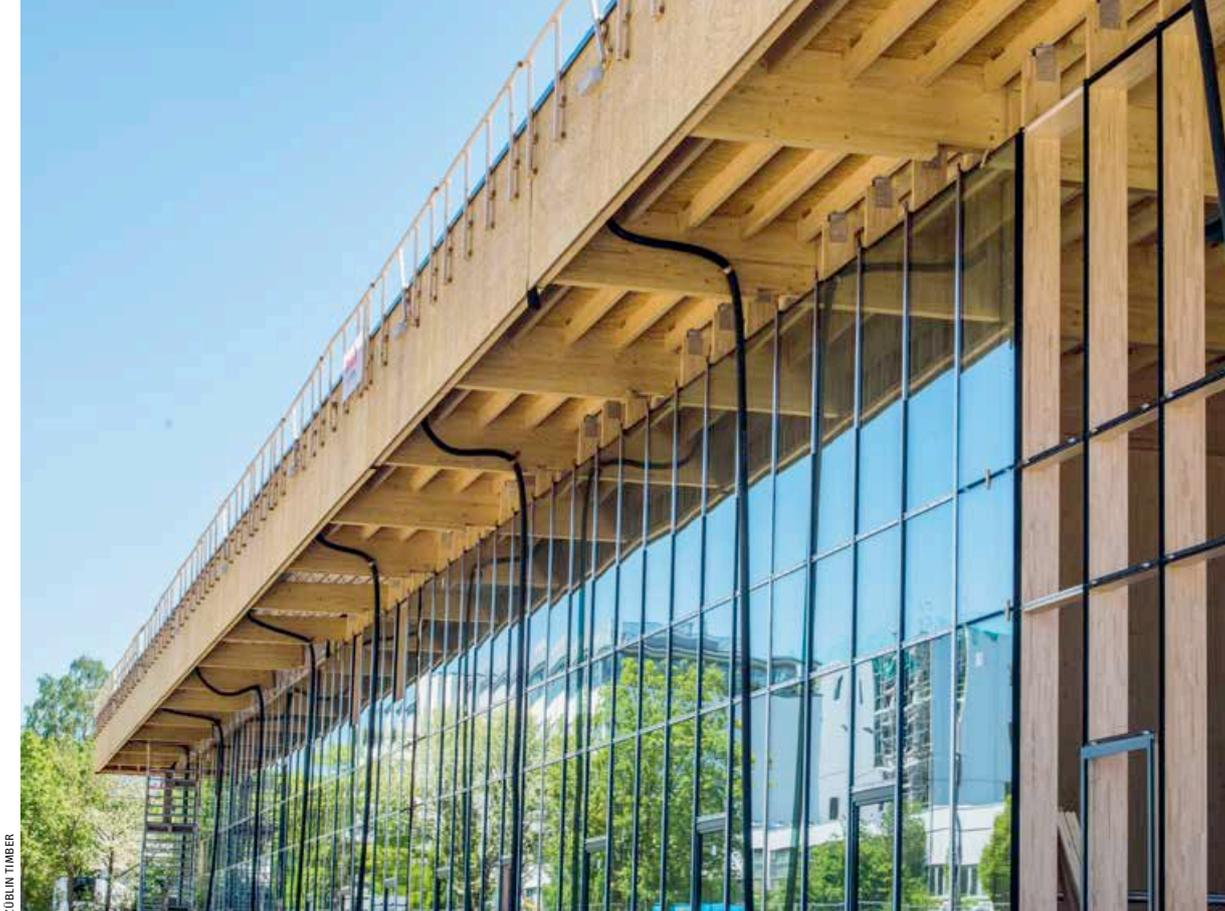
◀ Metalleinlagen in einigen der Pfosten erhöhen die Masse der Pfosten-Riegel-Konstruktion, sodass diese die schweren Schallschutzgläser trotz einer Pfostenbreite von nur 6 cm aufnehmen können
