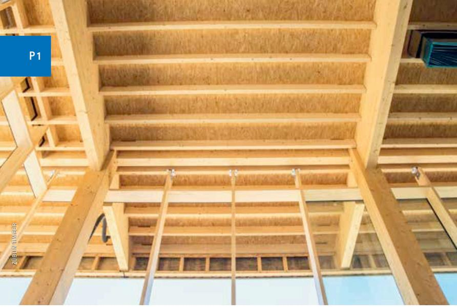
◀ Die Stützenköpfe der Brettstichholz-Stützen in den Außenachsen sind als Gabel-lager ausgeführt – sowohl im Bürobereich als auch im zweigeschossigen Bereich rund ums Foyer
