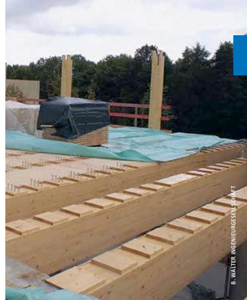
Dort sind die Balken über Ausklinkungen bzw. in Auflagertaschen auf dem Stahlbeton-Unterzug gelagert.
