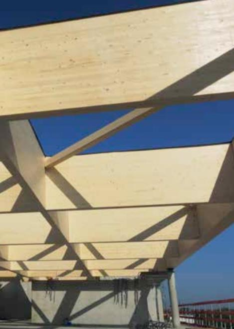
◀ Diagonalen im Verwaltungstrakt: In den äußeren zwei Kassettensreihen werden die Raster durch Diagonalen ausgesteift
