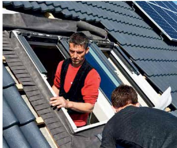
► Montage der Wasserab- leitrinne: Das Dämm- und Anschlussset ist exakt auf die Fenstergröße abgestimmt
