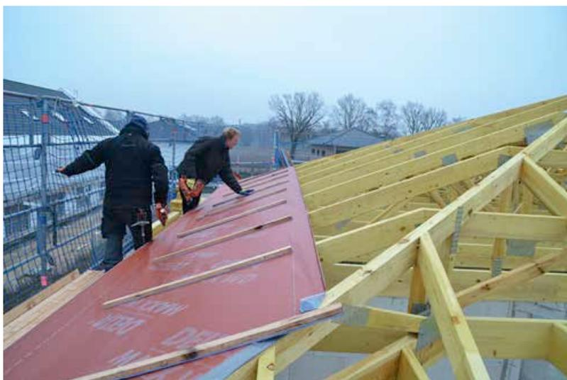
◀ **Neubau:** Unterspannung der Klasse 3 eines flach geneigten Dachs. Wird hier später eine Zwischensparrendämmung eingebaut, wird die nun aufliegende Bahn zur Unterdeckung
