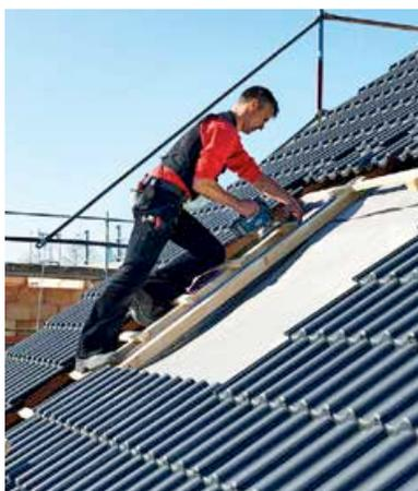
◀ Der Dachauschnitt wird nach den angegebenen Maßen hergestellt
