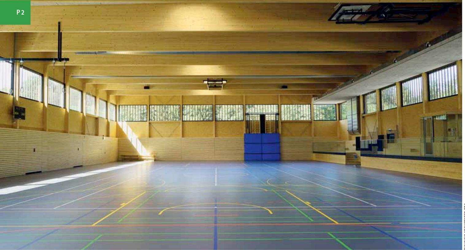
▲ Der Architekt setzte Fichte-Dreischichtplatten und Leimbinder als tragende Teile ein. Rechts in der Decke sind die Lüftungsleitungen und -öffnungen untergebracht
