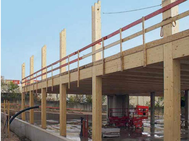
◀ Das Tragwerk im Laborbereich und Bürobereich bilden in den Außenachsen Stützen und Träger aus Brett-schichtholz
