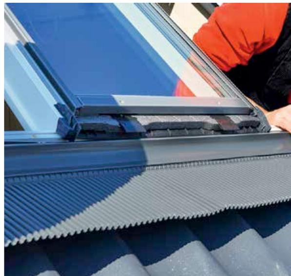
► Die ausge- hängten äußeren Fensterflügel erlauben Zim- merern ein bequemes Arbei- ten, hier bei der Montage der Ab- deckbleche
