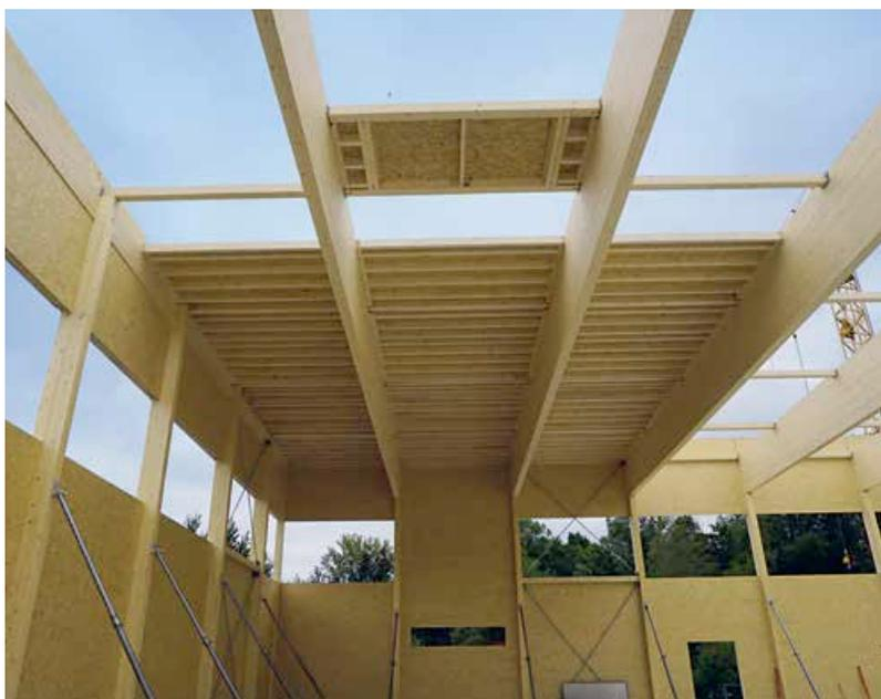
▲ Montage der elf Satteldach-Träger von 25,80 m Länge
