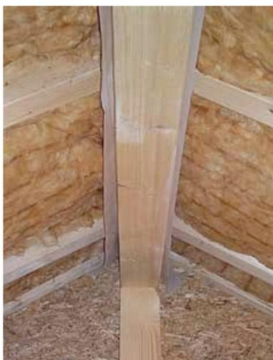
◀ Zwischen-sparrendämmung ohne Dampfbremsfolie
