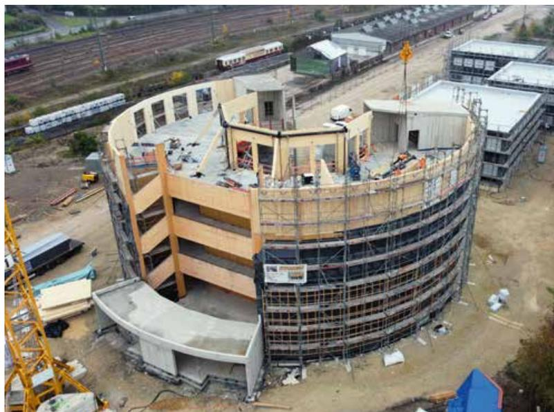
◀ Rohbau mit innerem Teil-„Ring“ aus polygonal angeordneten Wandelementen im dritten Obergeschoss. Gut zu sehen: der stählerne Druckring (schwarz) auf Wandkronenhöhe mit BSH-Druckstreben
