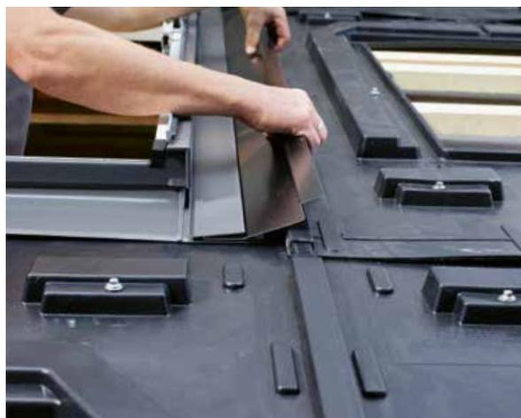
◀◀ Das Zusammenstecken muss präzise nach Einbauanleitung vorgenommen werden, damit eine durchgehende seitliche Nut entsteht
