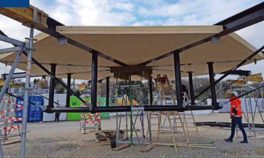
◀ Die achteckige Decke für die Dachterrasse bildet eine unterspannte Stahlkonstruktion mit BSP-Ausfachungen
