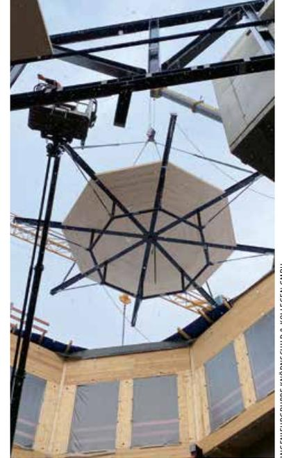
gesagt: Die Druckstreben leiten die Horizontalkomponente der Druckkraft in den Zugring ein und die Vertikalkomponente in die darunter liegende Innenwand.
