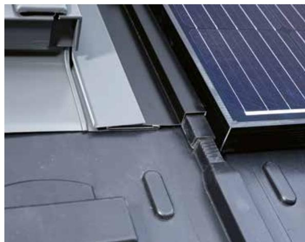
Lasche befestigen, danach seitliche Blendrahmen-Abdeckbleche von unten einschieben und mit einem hörbaren Klick einrasten lassen. Für diesen Teilschritt sind die bereits mit dem Blendrahmen verbundenen oberen Abdeckbleche vorübergehend noch einmal zu entfernen (ebenfalls werkzeuggesteuerfreie Klickverbindung). Abschließend kann das Eindeckrahmen-Oberteil aufgeschoben und exakt nach Einbauanleitung mit den Seitenteilen verbunden werden.
