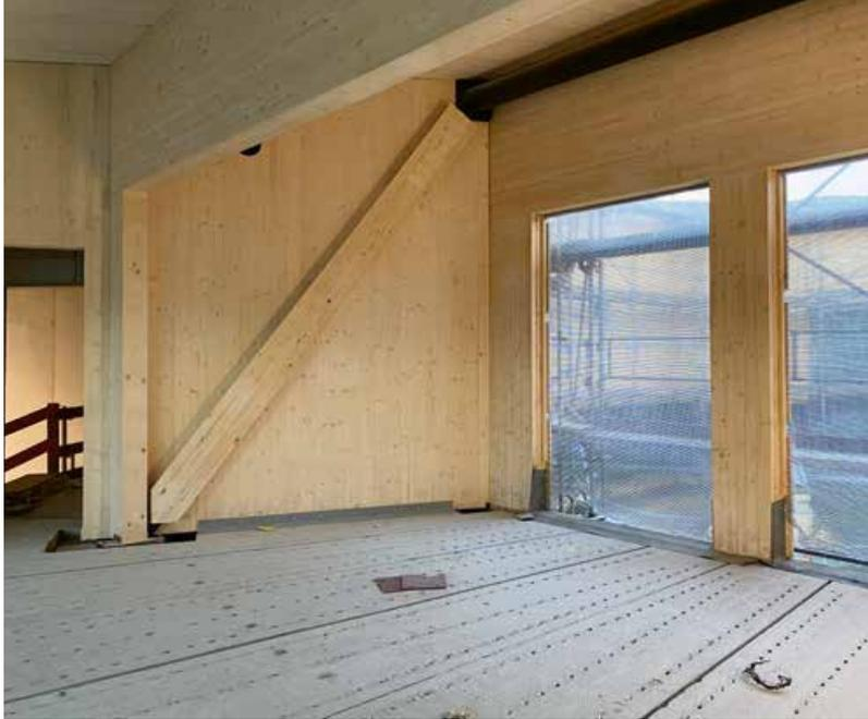
◀ Anschluss der Druckstreben an den Stahl-druckring oben und den Zugring unten
